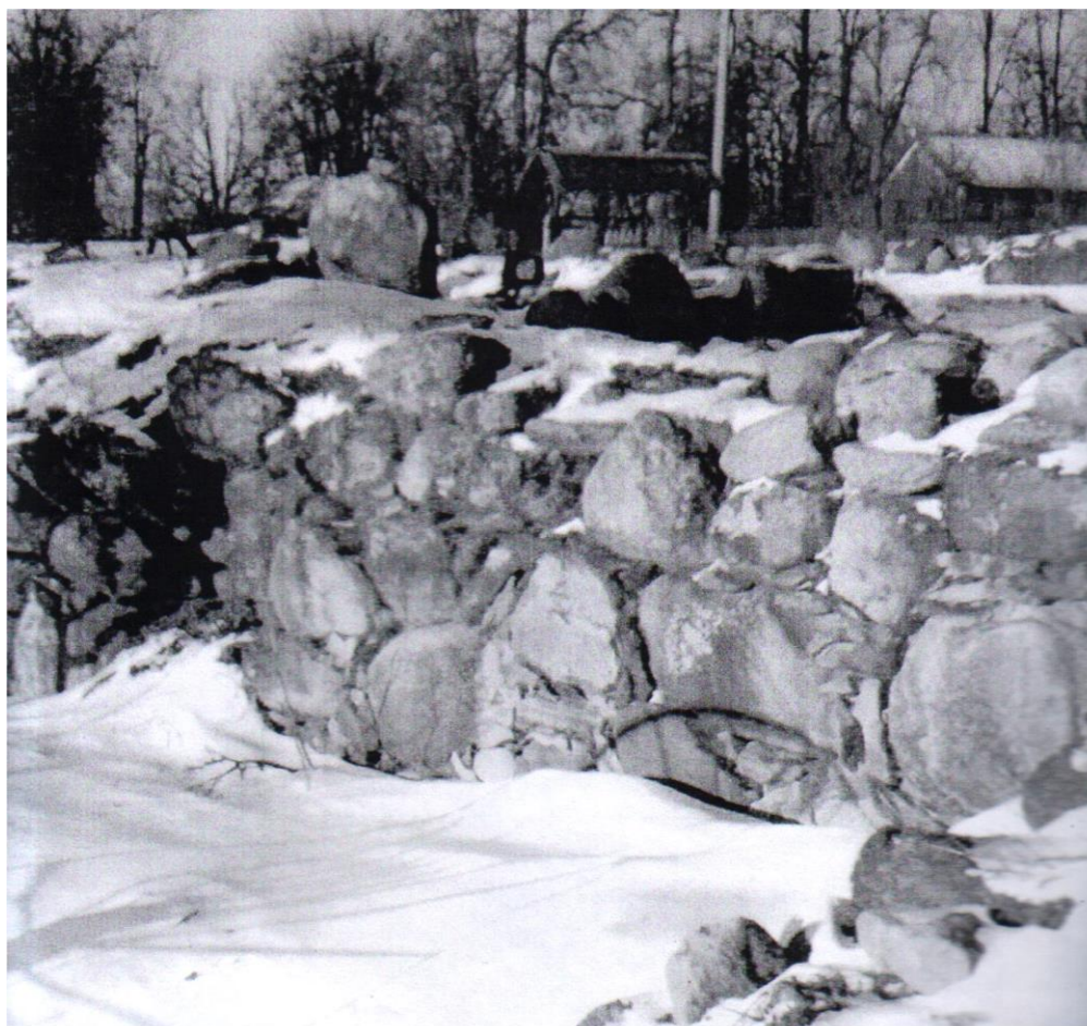
Остатки фундамента барского дома в ус. Горы.
