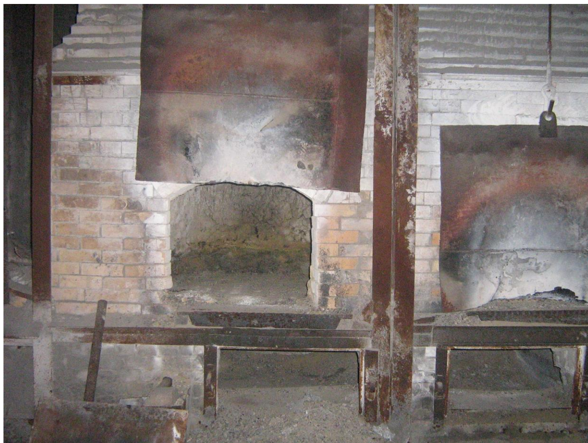
Печи витерильного цеха (фото 2008).
